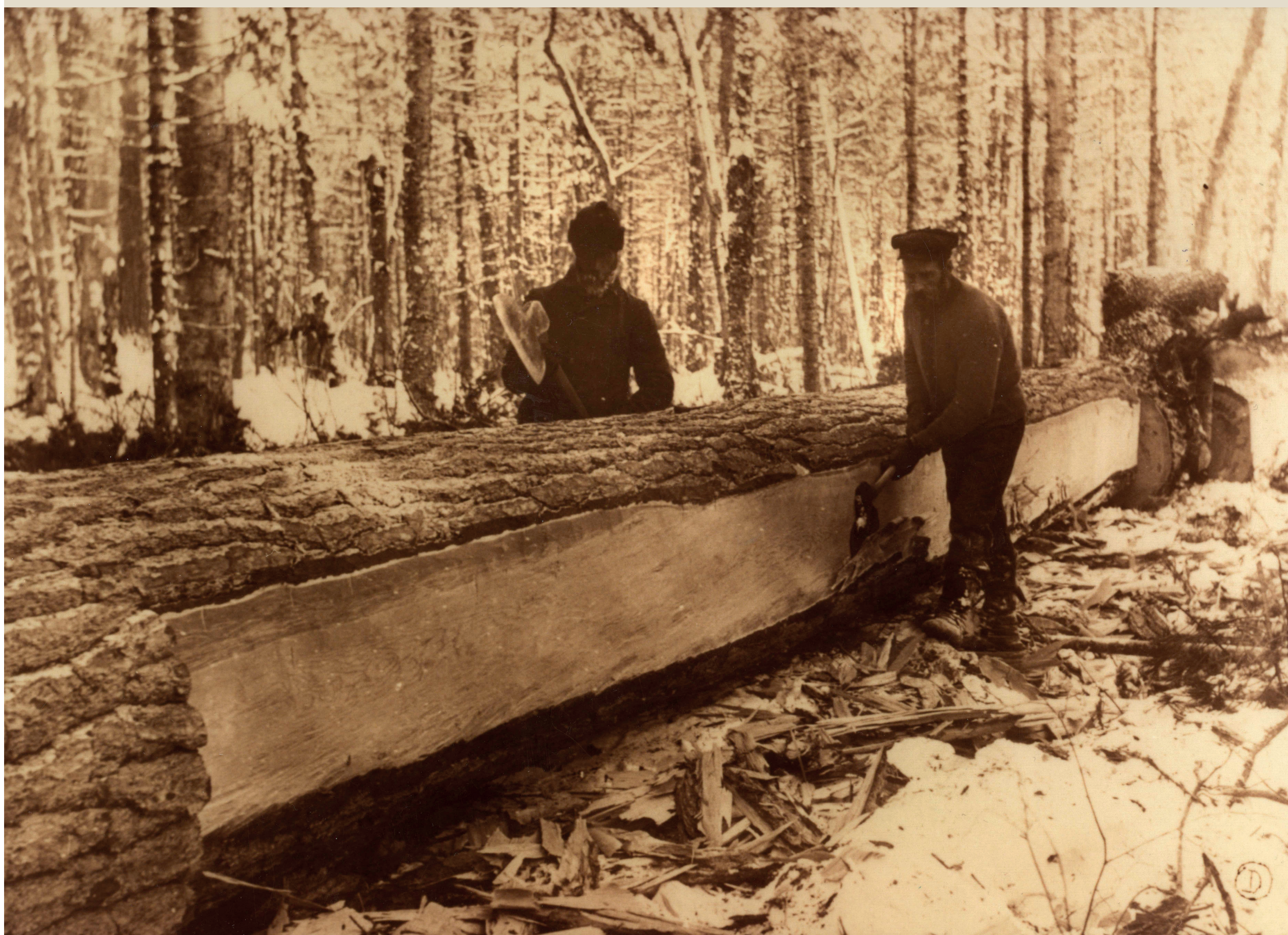
Équipe de bûcheron utilisant une hache à équarrir pour aplanir les faces d'un billot. Seconde moitié du 19 e siècle. © Société d'histoire et de généalogie des Hautes-Laurentides
