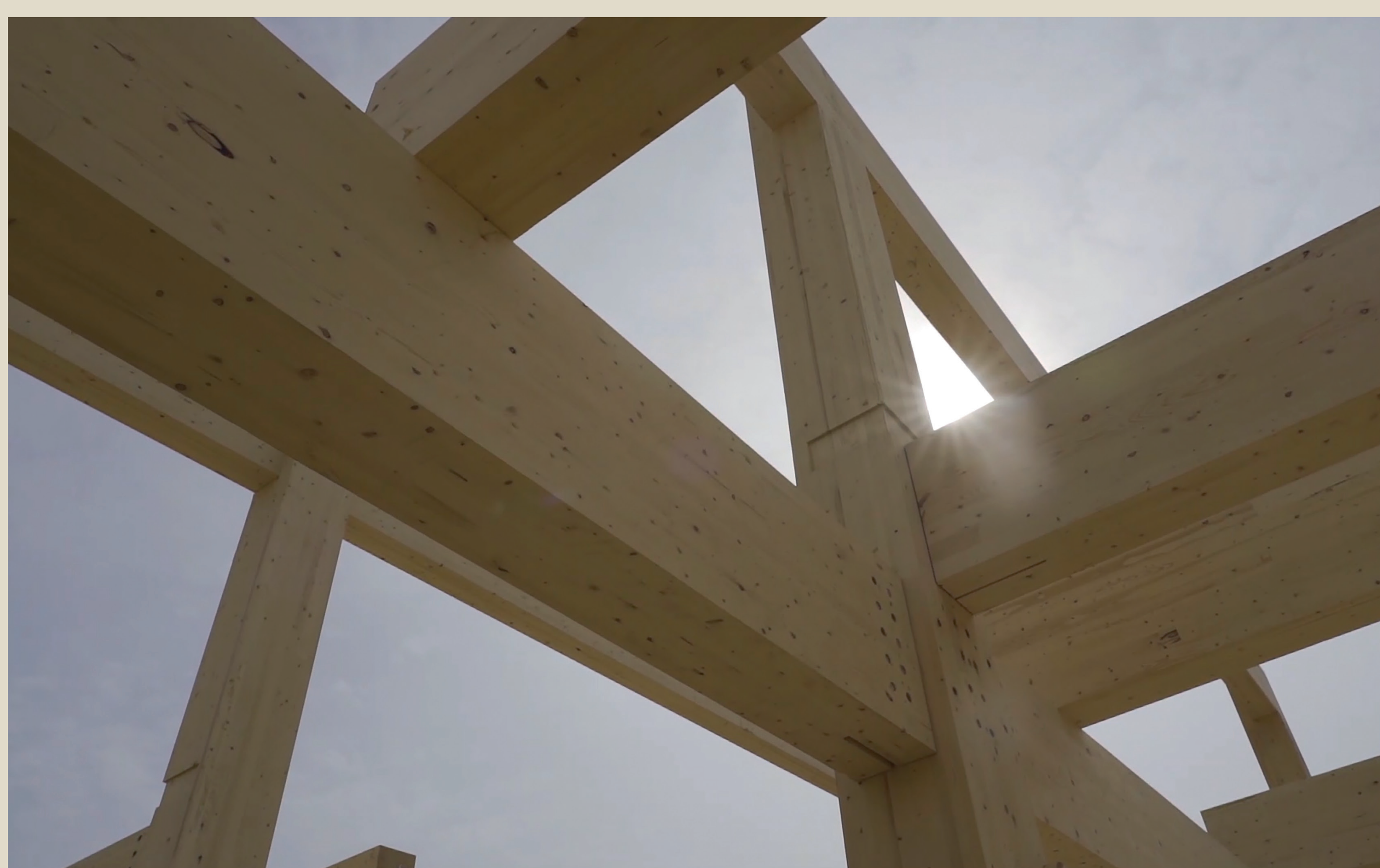
Structure massive en bois d'un immeuble commercial Extrait de la vidéo « Le cycle de la forêt laurentienne » disponible sur www.tableforet.ca/activites-autonomes © Nicolas Aubry
